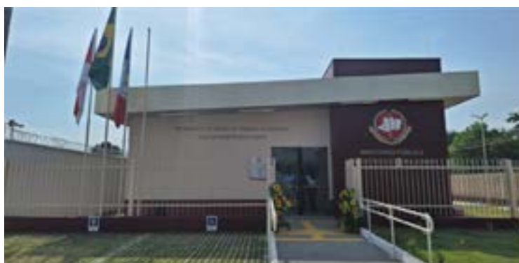
Figura - Construção Promotoria de Justiça de Manicoré – MP/AM.
