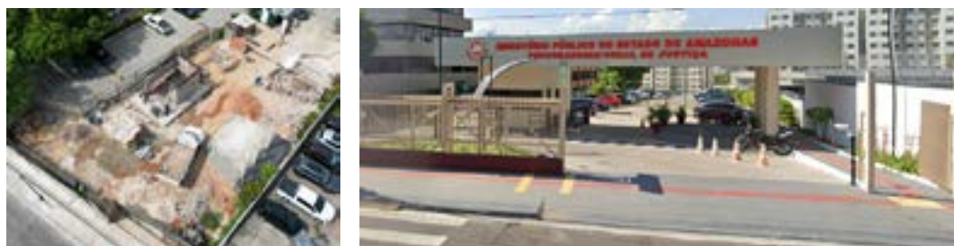
Figura - Obra Finalizada da guarita do prédio sede do Ministério Público do Estado do Amazonas – MP/AM
