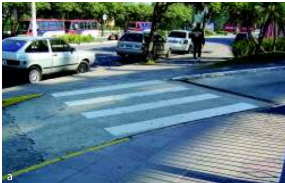
Fig. 5a e 5b. Abaixo, solução de travessia com faixa de segurança elevada, garantindo continuidade de percurso entre os passeios. À direita, balcão em duas alturas, permitindo o alcance por pessoas de diferentes estaturas e por pessoas em cadeira de rodas.
