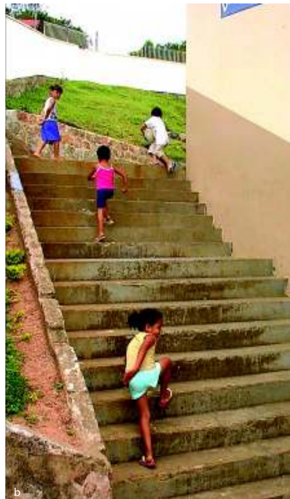
Fig.7a. A presença de torneiras com sistema de pressão ou automático não exigem força e coordenação motora, facilitando seu uso para crianças, para pessoas idosas, ou com artrite. Fig.7b. Degraus muito altos representam desconforto para todos, dificultam o deslocamento de pessoas idosas, gestantes e crianças, além de impedirem a mobilidade de pessoas com muletas e cadeira de rodas.
