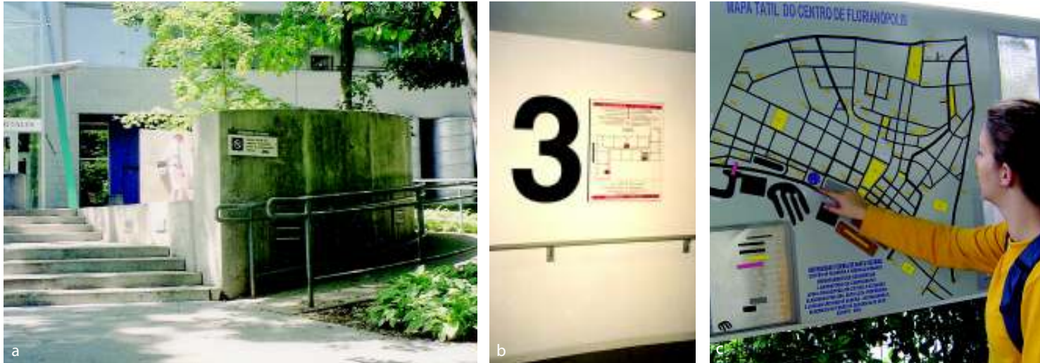
Fig. 3a, 3b e 3c – À esquerda, exemplo de entrada acessível de um edifício público, onde se pode observar a igual importância concedida à rampa e à escada. No centro, circulação interna, onde há clara identificação, no mapa, do pavimento, assim como dos serviços e direções existentes (pictogramas). À direita, presença de mapa tátil informa o sistema viário de um centro urbano.
