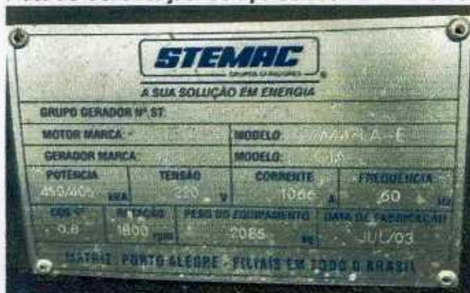
Placa de identificação -Gerupo Gerador STEMAC No. ST no.0450105203-Ativo 003434
