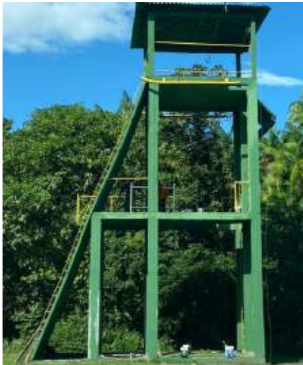
Rampa completa antes.
