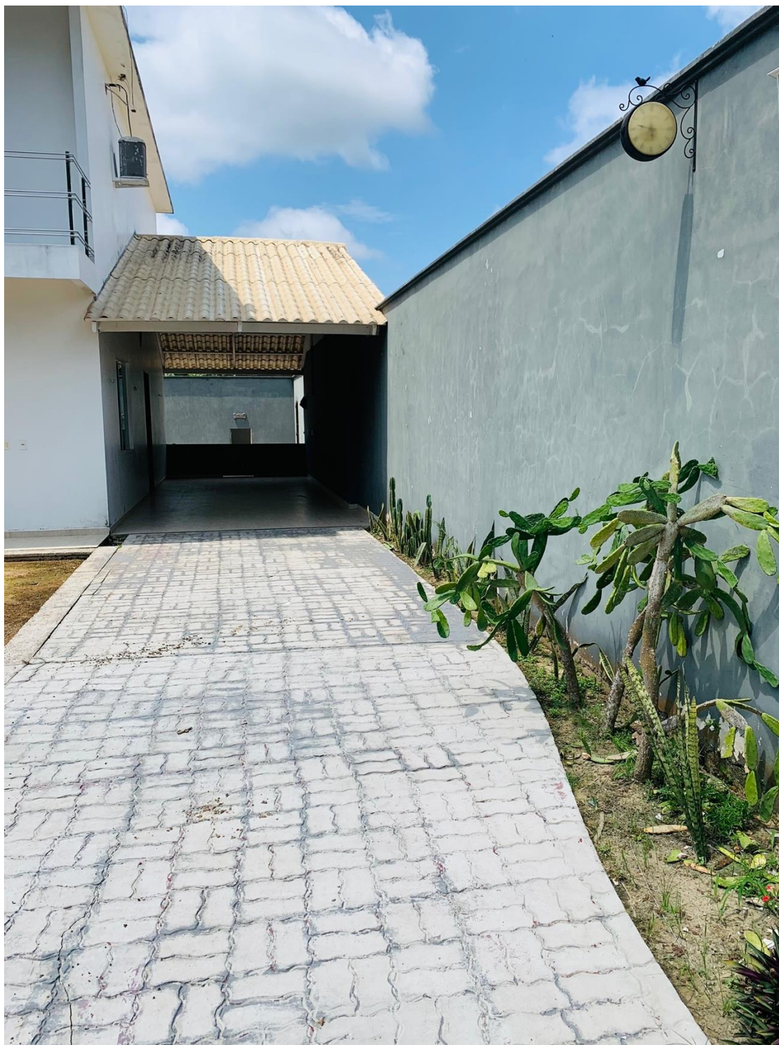
(FIG. 4 ENTRADA PRINCIPAL VISTA ANTERIOR) CONCRETO EM TODA ENTRADA PRINCIPAL ATÉ A GARAGEM.
