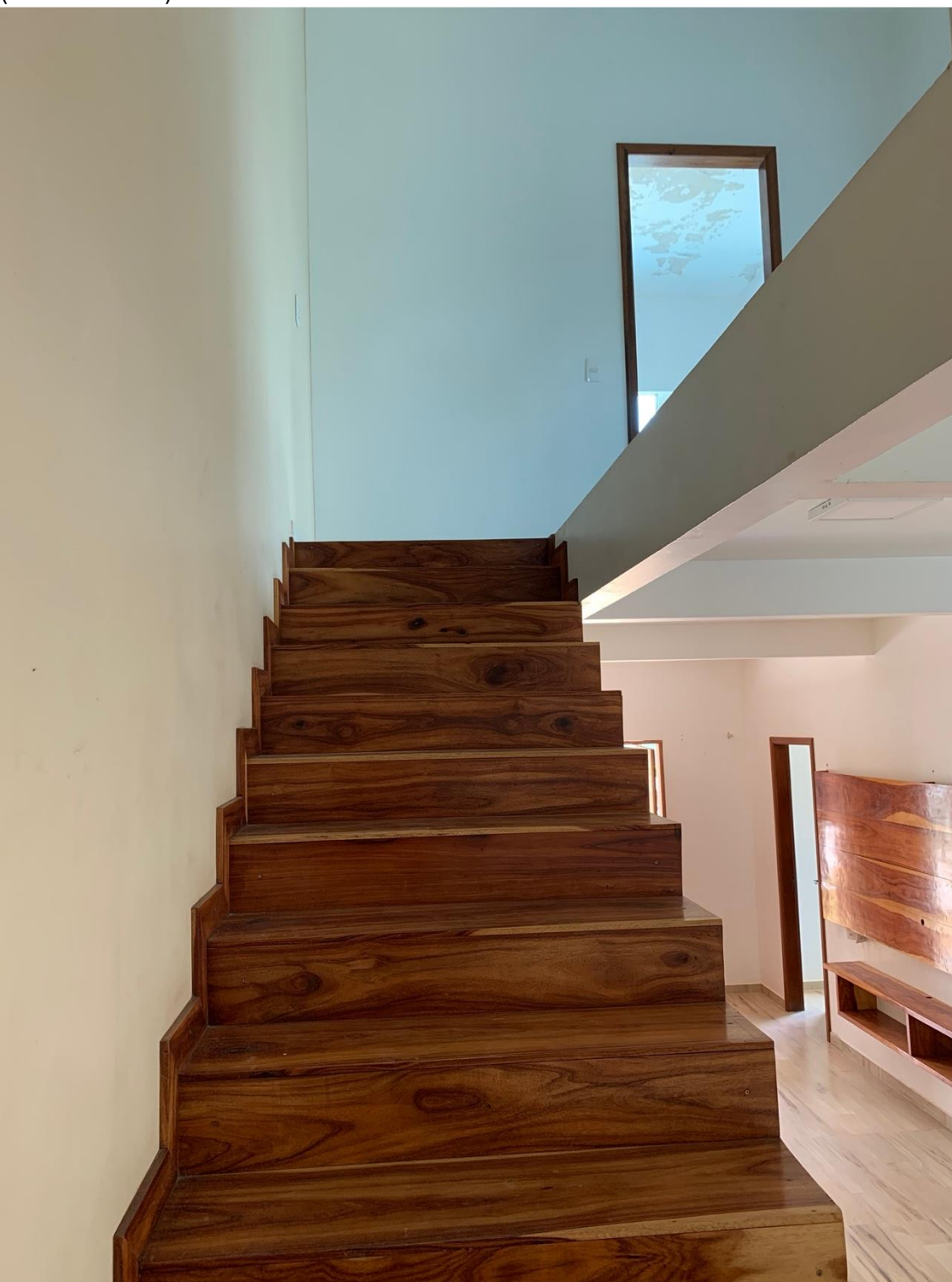
(FIG. 15 ESCADA EM CASCATA QUE DA ACESSO AO PISO SUPERIOR) REVERTIDA DE MADEIRA NOBRE (MACACAUBA)
